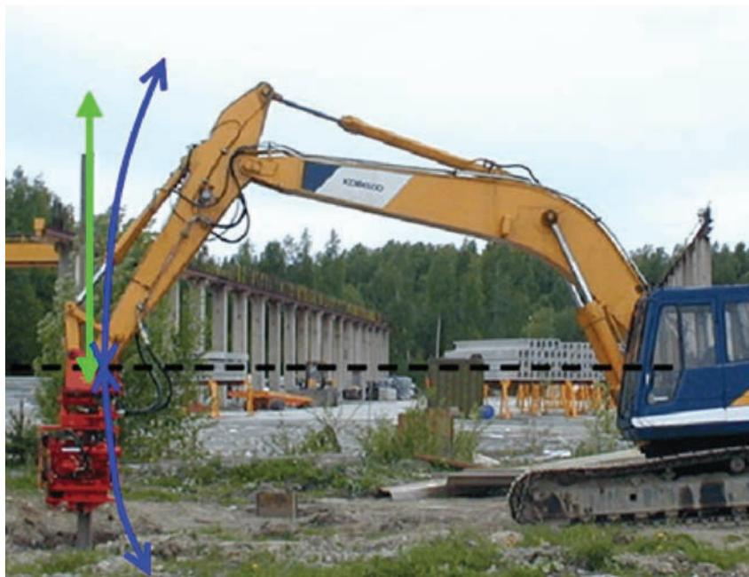
Рис. 4 Движение стрелы экскаватора при погружении шпунта
